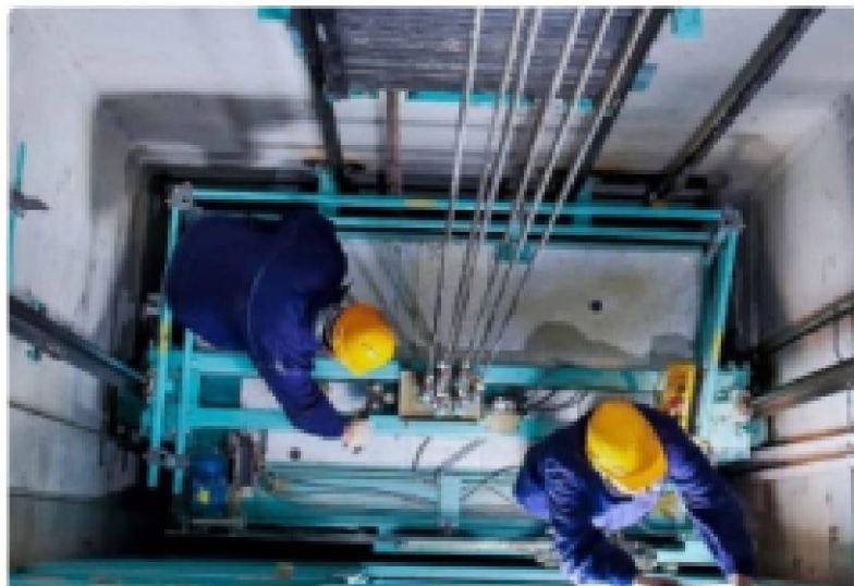
Обслуживание и ремонт лифтов
